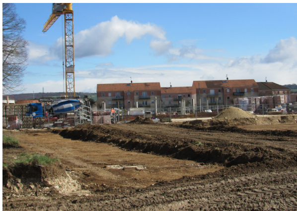
Ancienne friche militaire (Caserne Miribel) en travaux
